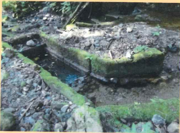
(中野水道取水口の遺構)
