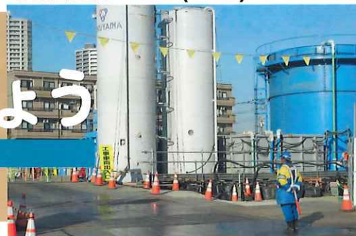
▲リニア駅西側工事風景（2021年1月）
